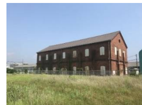
視点②隣接する煉瓦倉庫(旧水雷庫魚形水雷庫)
