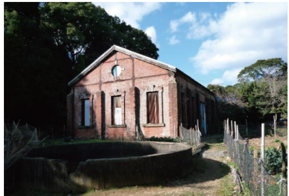
＜86. 旧黒島東砲台発電所＞大正3年（1914）に建造された砲台の発電所。佐世保軍港を守るためのもので、田代にも同じく砲台が作られた。
