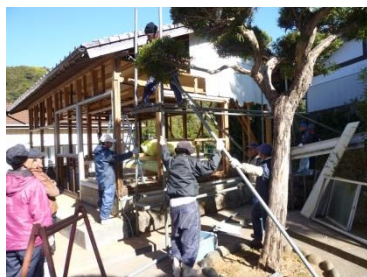
住民参加による改修
