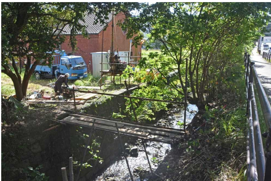
写真3.5 橋梁部 御船川右岸No.6掘進中 No.7足場を架設中 (北東側より撮影)
