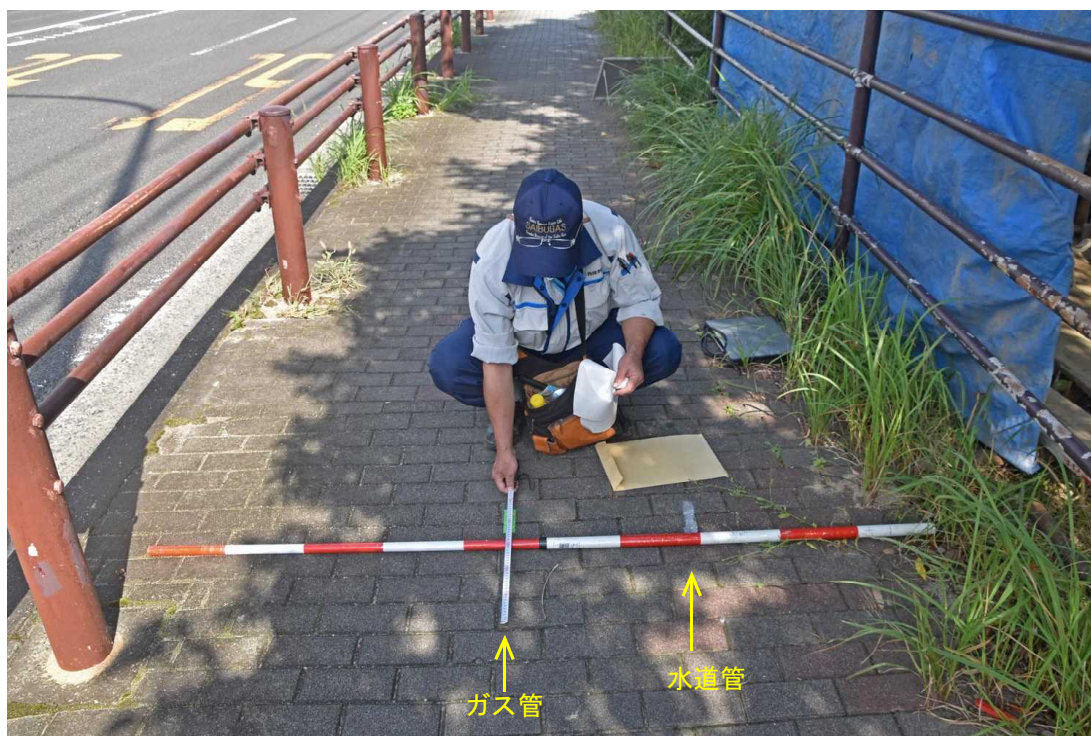
写真3.11 埋設物の現地調査(9月21日 西部ガスによる)
