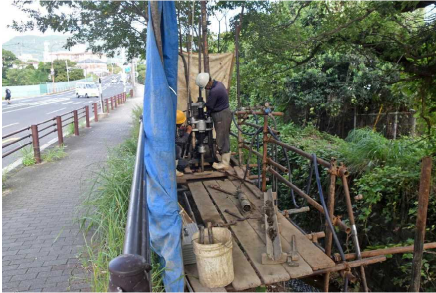
写真3.6 橋梁部 御船川左岸No.7掘進中 歩道に隣接
