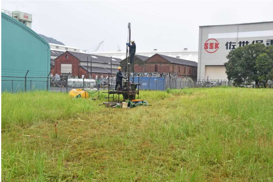
写真3.3 ガイダンス施設 No.2地点掘進中 (北東より撮影)
