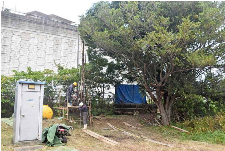
写真3.4 橋梁部 御船川右岸No.6掘進中 (南側より撮影)
