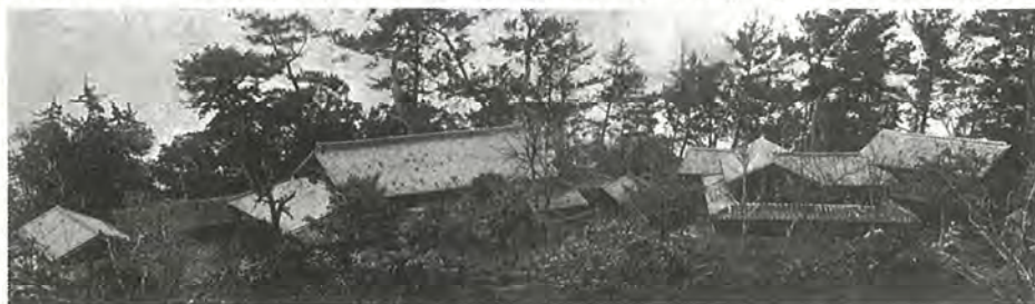
昭和4年頃の修道院全景『黒島修道院 100年の歩み』より
