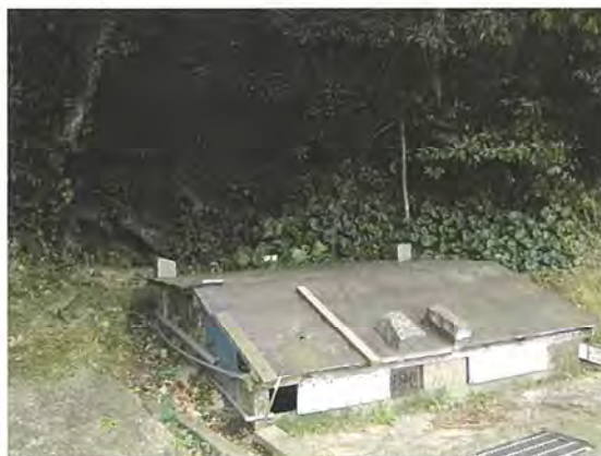
東堂平地区の貯水槽
