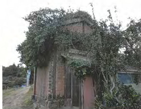
古里2番建物(探照灯格納庫)
