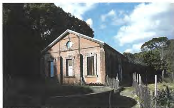
古里1番建物(発電所) 手前に水槽が見える
