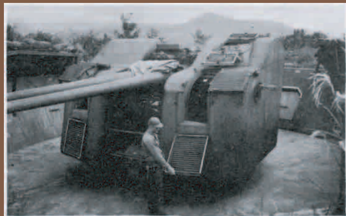
戦後に米軍の調査を受ける田島岳高射砲台の98式10cm連装高角砲
