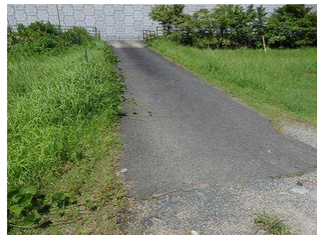
●橋梁への通路（アスファルト舗装）
