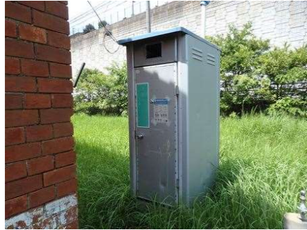
●トイレ① (仮設用トイレ)
