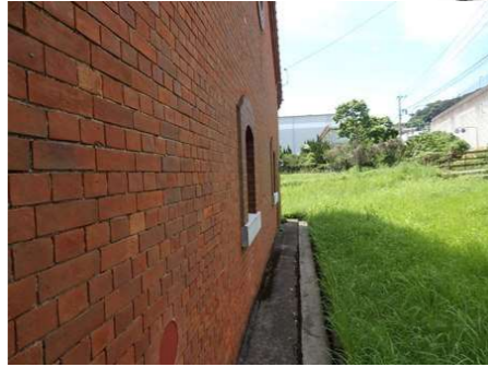
●煉瓦倉庫（東側部側溝）
