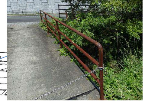
●既存橋梁手摺（錆腐食あり）
