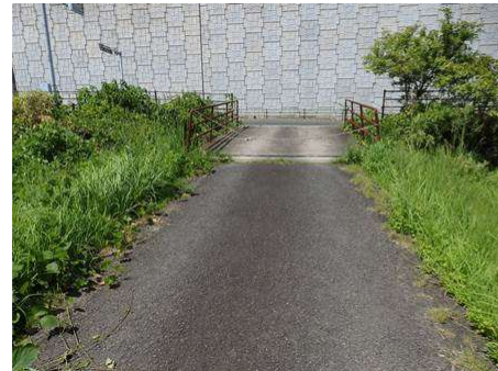
●橋梁への通路（アスファルト舗装）
