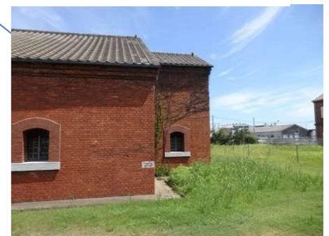
●煉瓦倉庫（西側部側溝）
