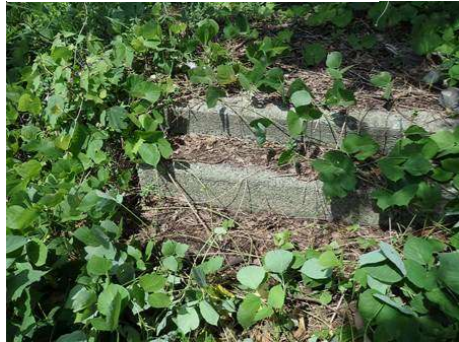
●堤防管理通路階段
