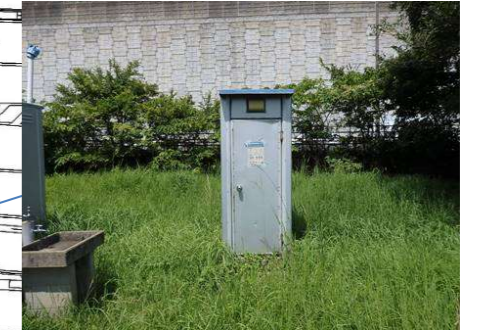
●トイレ② (仮設用トイレ)
