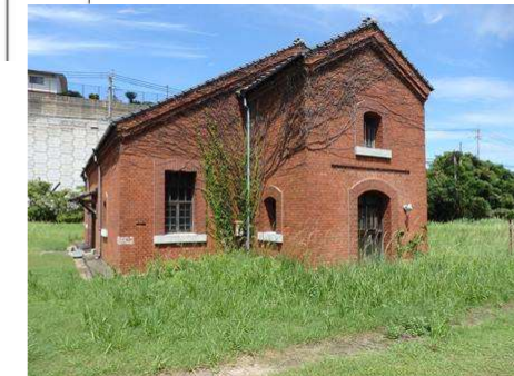
●煉瓦倉庫 (南側部正面)
