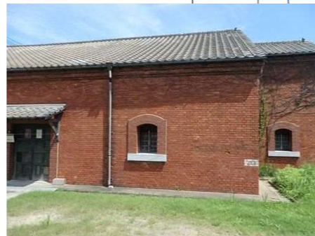
●煉瓦倉庫 (西側部)
