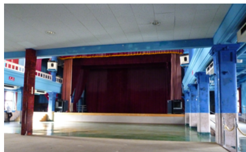
改修前の内部（平成 17 年）
