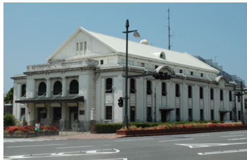
改修前の外観（平成 17 年）
