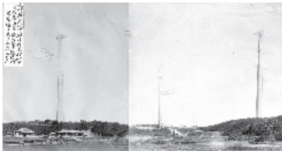
む せん とう 完成直後の無線塔全景
