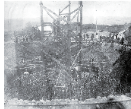
む せん とう けん せつ じ 無線塔建設時の写真
