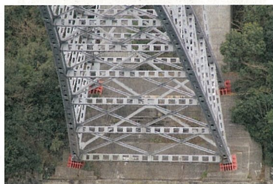
写真-7 西海市側支承部
