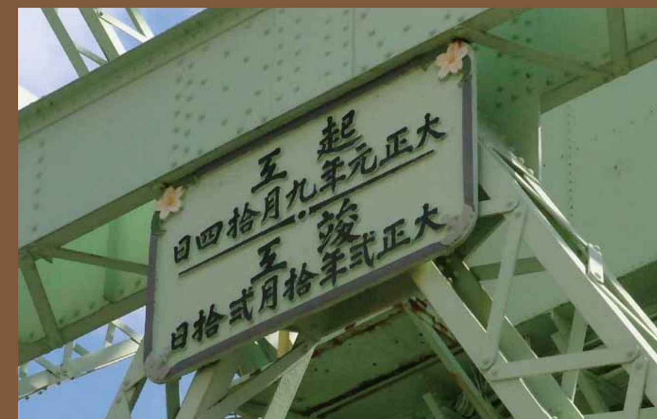
250トン起重機側面に取り付けられた銘板
