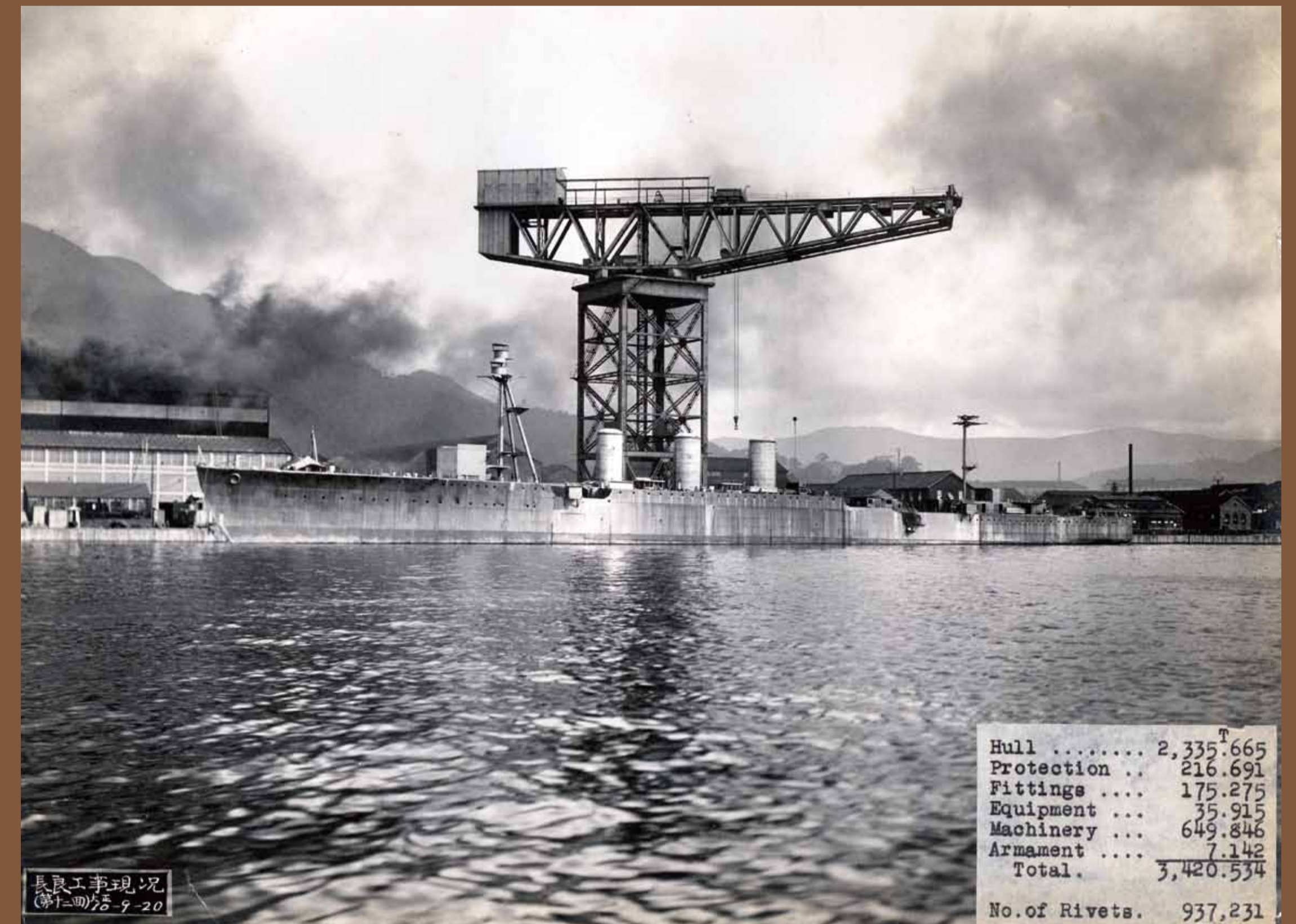
立神係船池で艤装を行う軽巡洋艦長良と250トン起重機
