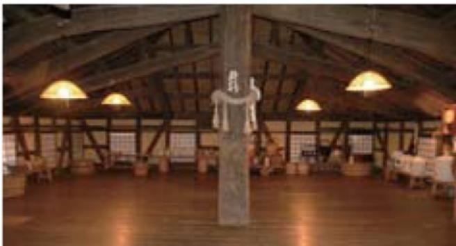
江迎本陣となった「山下家」は、元禄年間(1688～1703)創業の造り酒屋である。「酛蔵」は創業当初のものと伝えられ、平戸往還の本陣の中で、唯一当時の建物として現存している。酛蔵は酵母を作るための建物で、二階は四方に窓を設けるなど通風、湿度調節ができるようになっている。釘を一本も使わずに中央部に一階から二階を突き抜ける巨大な通し柱を建て、これに周囲すべての梁、桁をかけて屋根を支える極めて特徴のある構造である。これは柱を少なくして作業空間を確保するための工夫である。若干の改修は行われているが当初の形態を良く残している。
