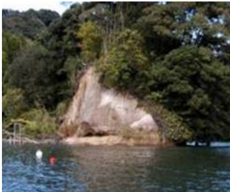
写真 36：ため池斜面の崩落
