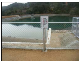
警告看板の設置
