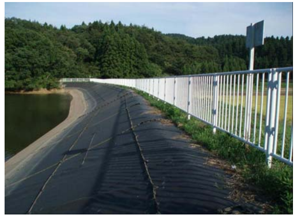
堤体法面に安全ロープの設置
