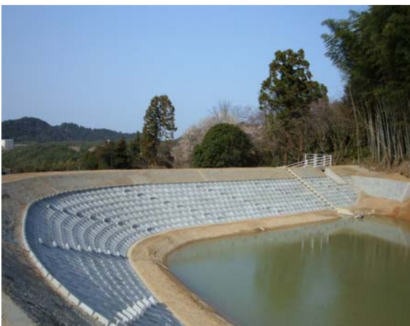
転落後の脱出可能となるような張ブロックの設置
