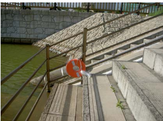
救命用浮き輪の設置
