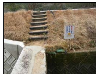
警告看板の設置
