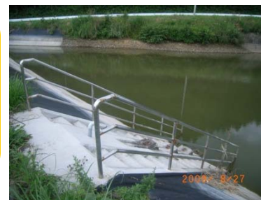
取水口階段・手摺設置状況
