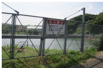
転落防止柵・警告看板の設置
