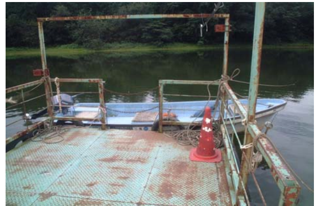
救命用ボートの常時設置
