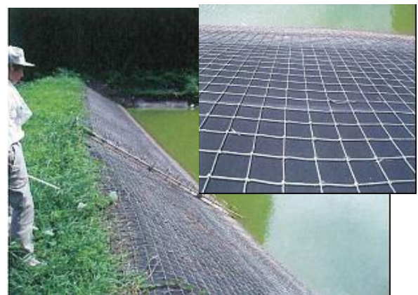
安全ネットの設置
