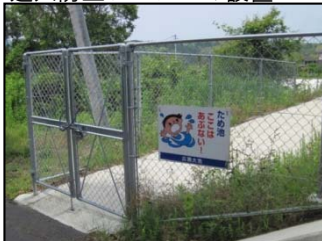
進入防止フェンスの設置
