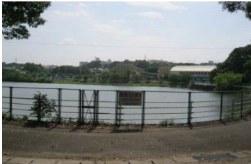
転落防止柵・警告看板の設置
