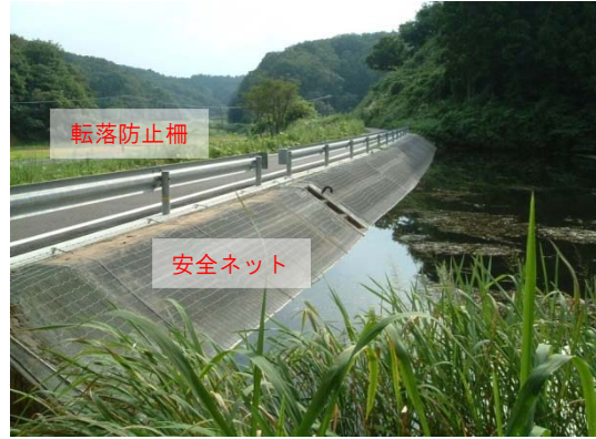
堤体法面に設置した安全ネット
