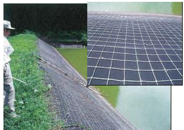
安全ネットの設置
