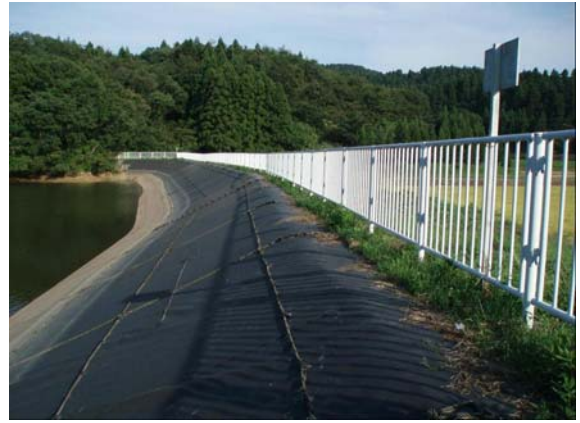
堤体法面に安全ロープの設置
