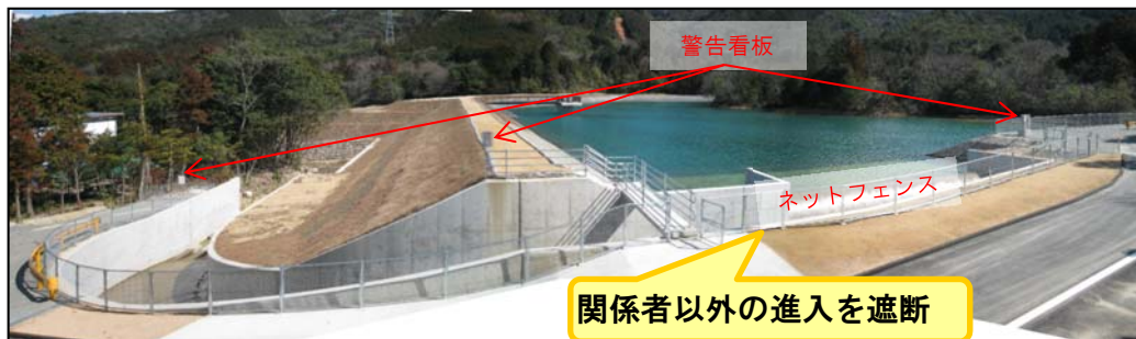
転落防止柵の設置
