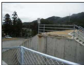
警告看板の設置
