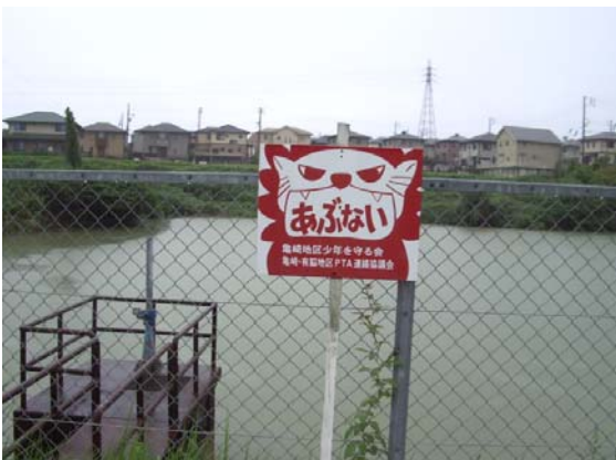
警告看板の設置②
