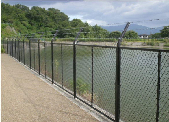
防護柵の設置
