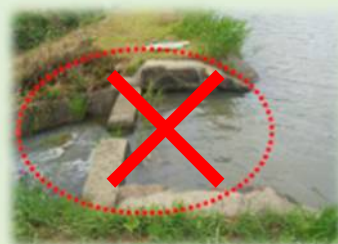
洪水吐の堰上げ
