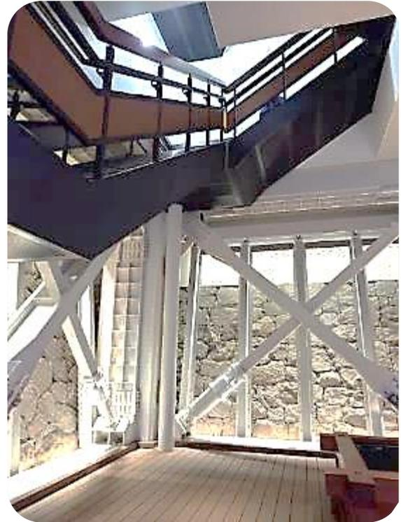
天守閣の内部はブレース(筋交い)で補強しており、見学ルートが整備されています。
