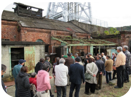
【熊本】ユネスコ世界遺産 万田坑 保存されている、レンガ造りの重厚な建物そのものも見応えがあり、巨大な機械が残された機械室など、迫力満点でした！！
