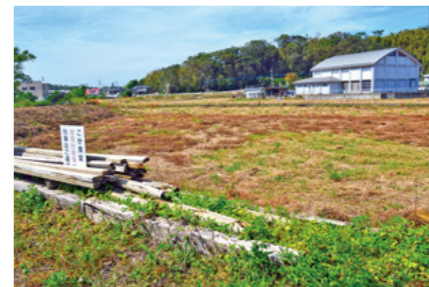
●令和2年9月8日 造成工事前 多菜房こが駐車場より
