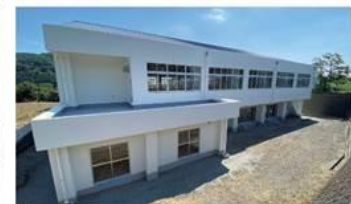
(裏側) 舗装工事がこれから始まります
