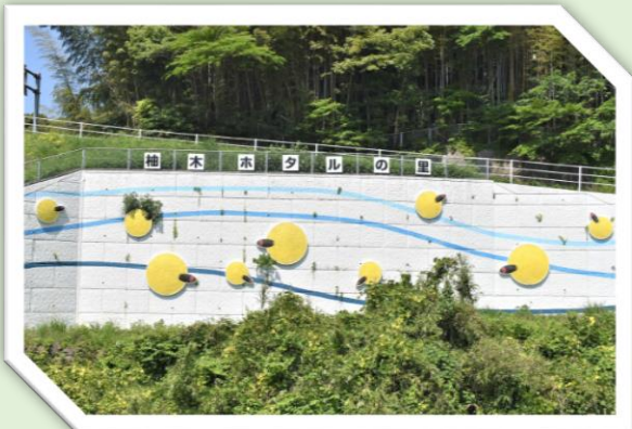
道路側壁の「柚木ホタルの里」
