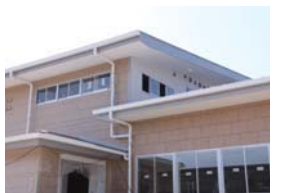
建設中の学校給食センター (平成25年3月撮影)
