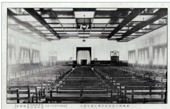
絵葉書9 県立佐世保中学校講堂(昭和初期建築、平成16年解体)
