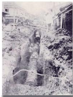
市最初の水道管敷設工事
