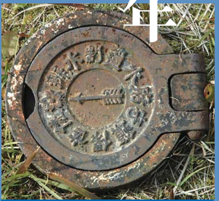
佐世保鎮守府水道制水弁
