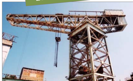
佐世保重工業(株)佐世保造船所 ・250トン起重機（クレーン）
