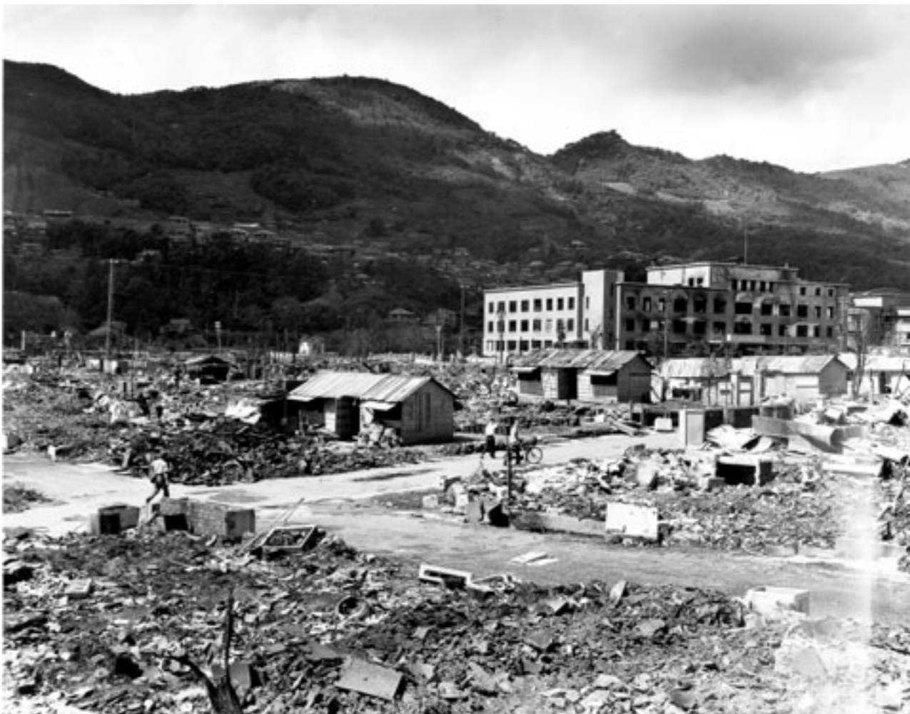
被災地跡に当座しのぎのバラックが建ち並ぶ市役所付近。9月23日撮影。写真提供／芸文堂
