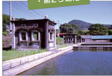
山の田浄水場 ・第2ろ過池
