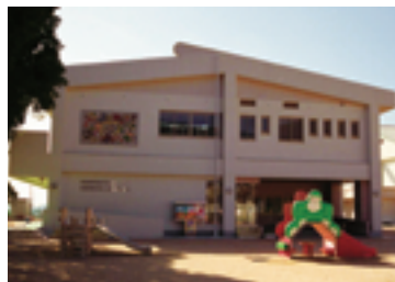
同センターの1階には白南風幼稚園が併設されています。吹き抜けが設けられ、2階から園の様子を見ることができます。
