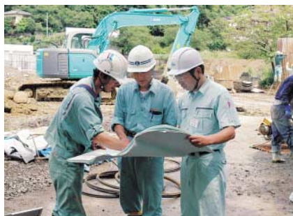
清水小学校建設現場で基礎工事の打ち合わせをする職員と業者
