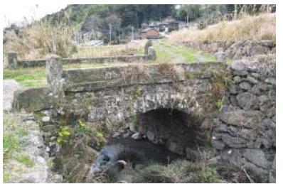
△きりのき橋(世知原町北川内)
