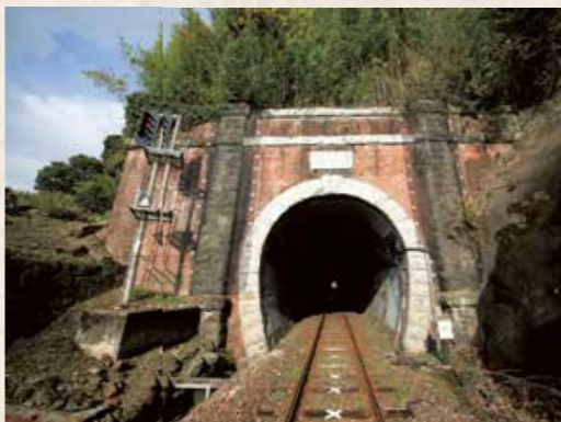
南風崎トンネル第五号隧道
