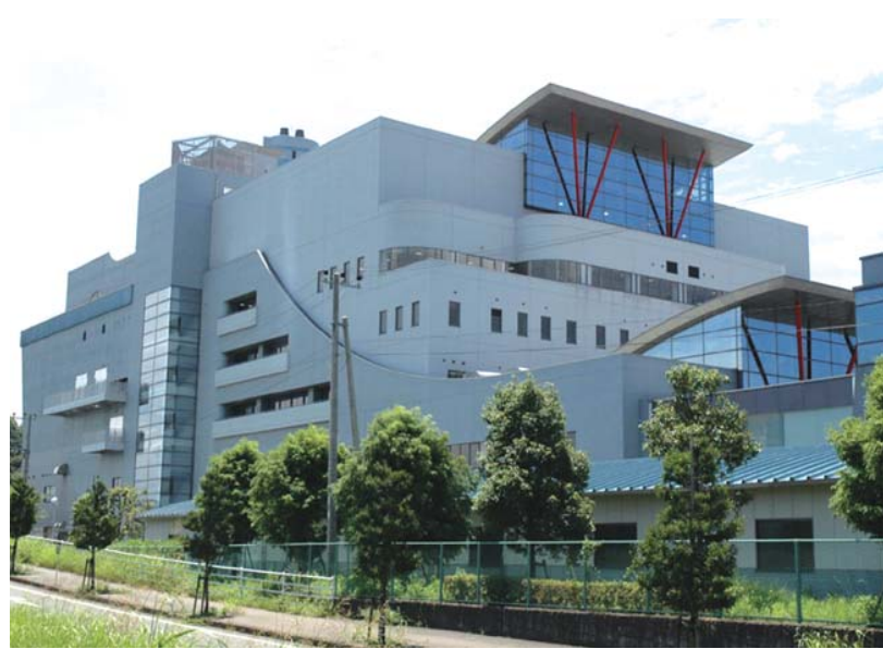
【東部クリーンセンター（大塔町）】 東部クリーンセンターは、日量200トンの焼却能力があり、環境に配慮した最新技術を備えた施設として、平成13年から稼働しています。また、十分な公害防止対策を施し、安全性や周辺の景観との調和にも配慮しています。 施設内では、ごみ焼却で得られた熱を利用し、蒸気タービンによる発電を行って、東部クリーンセンターで必要な電力をまかない、余った電力は電力会社に売電しています。
