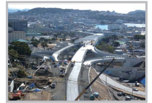
佐世保中央インターチェンジ付近の遠景 (平成22年1月26日撮影)
