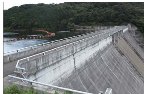
かさ上げ工事を実施した下の原ダム
