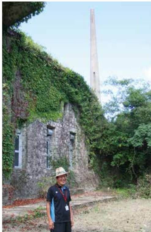
電信室と無線塔(2号塔)
