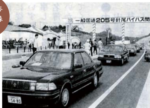
8月11日、国道205号針尾バイパス全線開通。第2期工事(指方-南風崎間2.2km)完成
