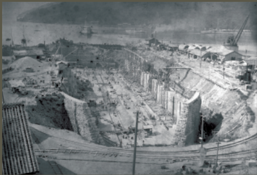
旧佐世保海軍工廠第一船渠(現佐世保重工業株式会社佐世保造船所第5ドック) 本市の水道をはじめ西日本各地で水道建設に携わり、「水道の父」と称された吉村長策氏の遺品の中に含まれていた写真。吉村氏は佐世保鎮守府経理部建築科長というポストに就いており、改修用の資料としてこの写真を入手したと考えられます。写真右上には明治23年に完成した50トンのクレーンが、ドック後方海上には帆走練習艦「満珠」やドイツから輸入した22号型水雷艇らしい艦影が写っています。
