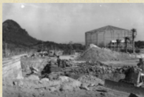
建設途中の動植物園(昭和34年)
