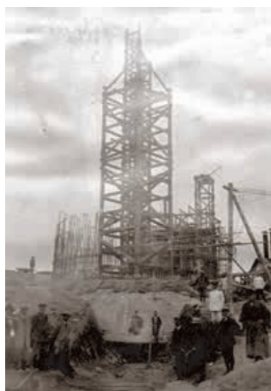
基礎工事が完了した針尾無線塔
