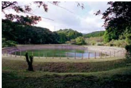
佐世保市水道局岡本水源第2貯水池 (旧海軍水道皆瀬水源第2沈殿池、明治33年、十文野町) 設計は水道の父と称された吉村長策。日露戦争に備えて整備を急ぎ、農業用の溜め池を貯水池に改造しました
