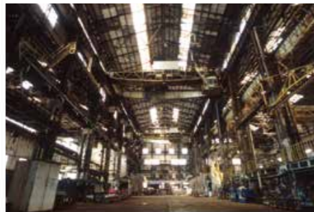
佐世保重工業(株)佐世保造船所組立工場 (旧佐世保海軍工廠造船部組立工場、大正8年、立神町) 外壁はレンガ造ですが、本体は鉄骨造。複雑な鉄骨の組み合わせにより迫力ある大空間が構成されています
