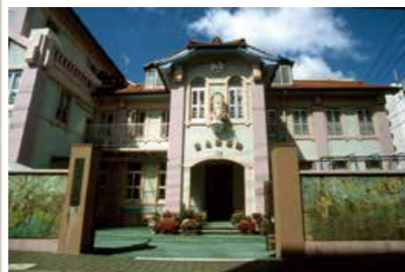
(株)純心女子学園聖心幼稚園 (三浦町、昭和5年) 三浦町教会の付属施設として建てられ、鉄川与助氏が設計を手掛けた教会以外では数少ない鉄筋コンクリート造建築の現存例。就学前教育は戦前から重要視されていました
