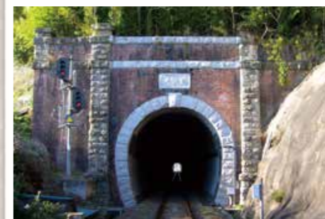
九州旅客鉄道(株)大村線南風崎トンネル (旧九州鉄道(株)第五号隧道、明治30年、南風崎町) 正面に見える石造りの柱は構造上というより意匠的なもの。この時期の建造物の特徴の一つになっています
