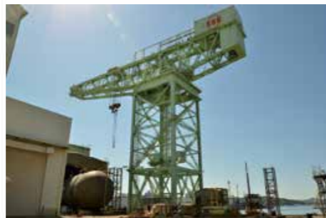
佐世保重工業(株)佐世保造船所250トンの起重機 (大正2年、立神町) イギリスのサー・ウィリアム・アロル社に発注されたジャイアント・カンチレバー・クレーン。日本に3台、世界にも11台しか残っていません
