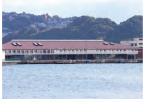
平成27年4月に供用開始になった「葉港テラス」。お出迎えやお見送りができる送迎デッキの他、国際定期船の就航を見据え、外貨貨物の保管や検査を行うための施設も備えています
