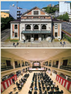
佐世保市民文化ホール (旧佐世保鎮守府凱旋記念館) 鉄筋コンクリート及び煉瓦造2階建て 大正12(1923)年 第一次世界大戦の凱旋記念館として建設された。一見すると鉄筋コンクリート造のように見えるが、柱が鉄筋コンクリート造で、外壁は煉瓦造である。海軍用地の入口付近に建ち、記念館として公堂的な役割があったため極めて装飾性に富んだ建物となっている。
