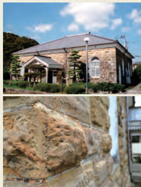
佐世保市世知原炭鉱資料館 (旧合資会社松浦炭坑事務所) 石造平屋 大正元(1912)年 昭和45(1970)年の炭鉱閉山まで事務所として使用されていた。付近で採れる砂岩をブロック状に切り出して積み上げている。東北地区に現存する唯一の石造洋風建築。小屋組みの鉄骨トラスは古材の再利用品である。
