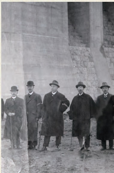
海水をくみ出した状態の立神係船池の岸壁の前に立つ吉村長策（中央）と真島健二郎（右から2人目）。2人が中心となって進められた立神係船池の建造は11年の歳月をかけ、大正5（1916）年に完成。明治時代における海軍最大の土木工事で、施工技術も日本最高と評されました
