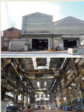
佐世保重工業株式会社組立工場 (旧佐世保海軍工廠造船部組立工場) 鉄骨造平屋 大正8(1919)年 複雑な鉄骨の組み合わせにより迫力のある大空間が構成されている。鉄骨造工場建築の真骨頂とも言うべき魅力的な光景である。明治期までの鉄骨造建物はイギリスなどの外国からの輸入材を使っているが、大正時代に入ると国産材を使うなど、技術の発展過程を見ることが出来る。
