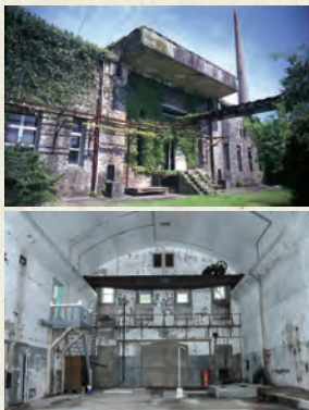
旧佐世保無線電信所電信室 鉄筋コンクリート造2階建て 大正11(1922)年 現在は1階部分が埋められており、半地下式となっている。長波送信施設として建設された佐世保無線電信所(針尾送信所)の中心に位置し、発電と送信を行うための施設だった。防空防衛も考慮していたのか極めて頑丈な建物である。
