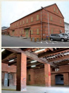
米海軍佐世保基地311号建物 (旧佐世保鎮守府需品倉庫煉瓦倉庫) 煉瓦造2階建て 明治21(1888)年 佐世保鎮守府建設の第一期工事で軍需品を保管する倉庫として建てられた。シンプルな建物であるが、外壁に焼過煉瓦を用いた三条の帯が装飾してある。311号建物は平成24年から26年にかけて電話交換機室へと改装され、内装は全て撤去されてしまったが、外観についてはほぼ旧来の姿を留めている。
