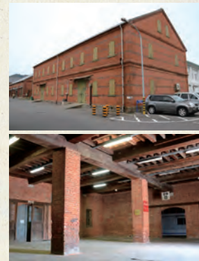
米海軍佐世保基地311号建物 (旧佐世保鎮守府需品倉庫煉瓦倉庫) 煉瓦造2階建て 明治21(1888)年
