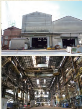
佐世保重工業株式会社組立工場 (旧佐世保海軍工廠造船部組立工場) 鉄骨造平屋 大正8(1919)年
