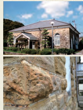
佐世保市世知原炭鉱資料館 (旧合資会社松浦炭坑事務所) 石造平屋 大正元(1912)年
