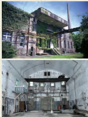
旧佐世保無線電信所電信室 鉄筋コンクリート造2階建て 大正11(1922)年
