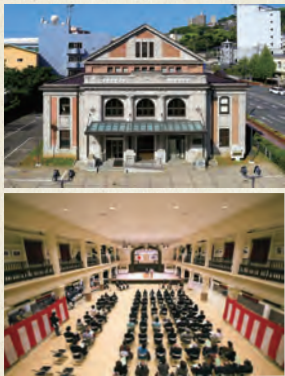
佐世保市民文化ホール (旧佐世保鎮守府凱旋記念館) 鉄筋コンクリート及び煉瓦造2階建て 大正12(1923)年
