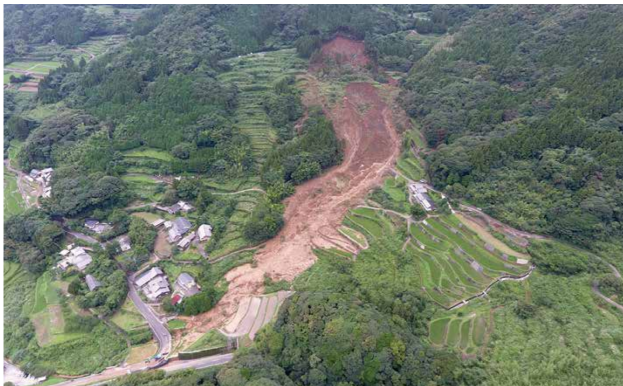
7月10日の大雨によって崩落が発生した牧の地乙石尾線一帯(小川内町、ドローンによる撮影・大栄開発株式会社提供)
