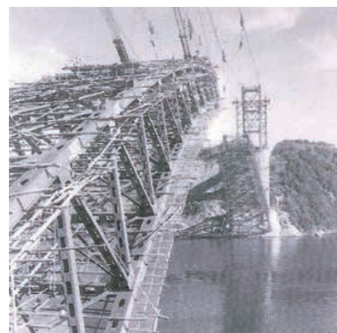
アーチの工事
