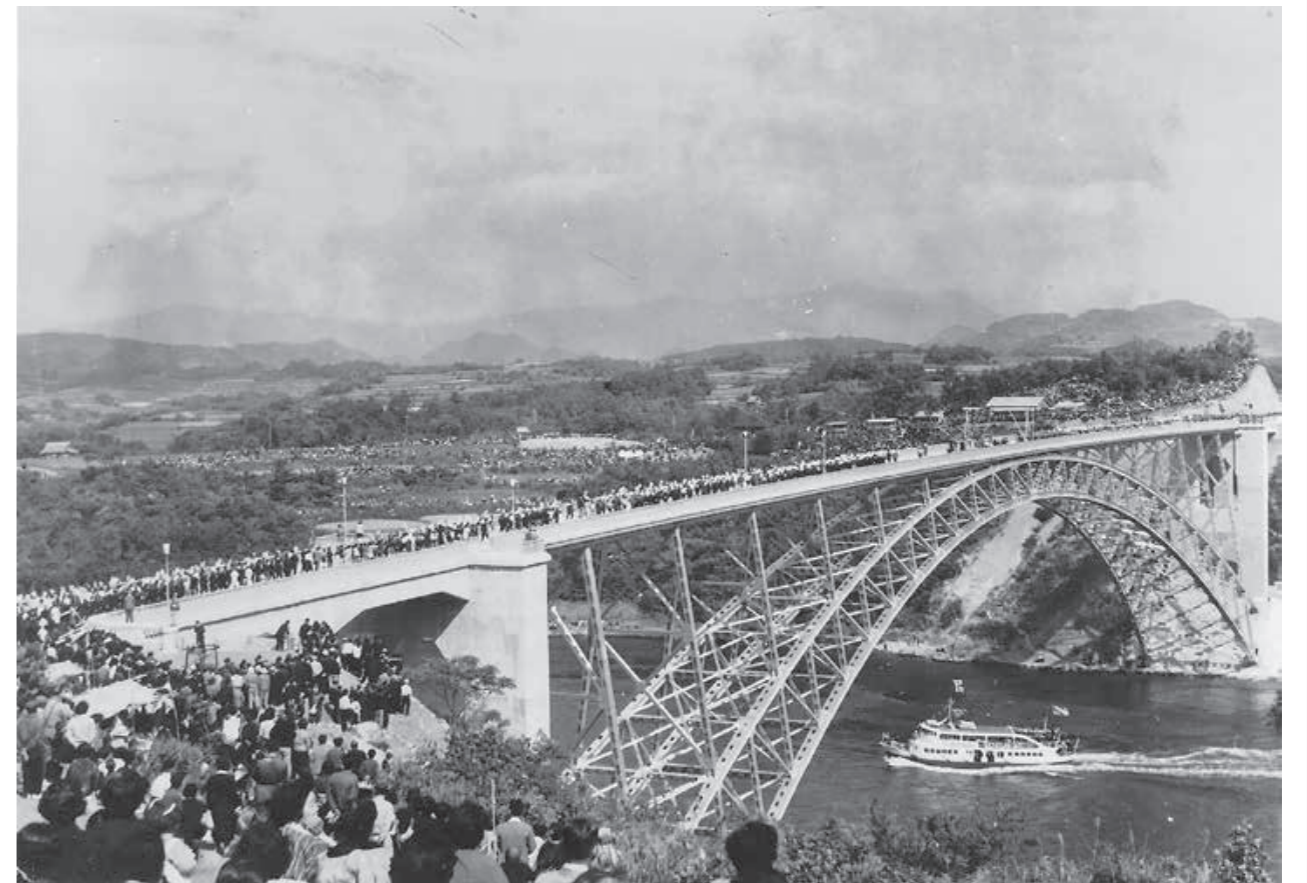
多くの観光客でにぎわう開通した当時の「西海橋」
