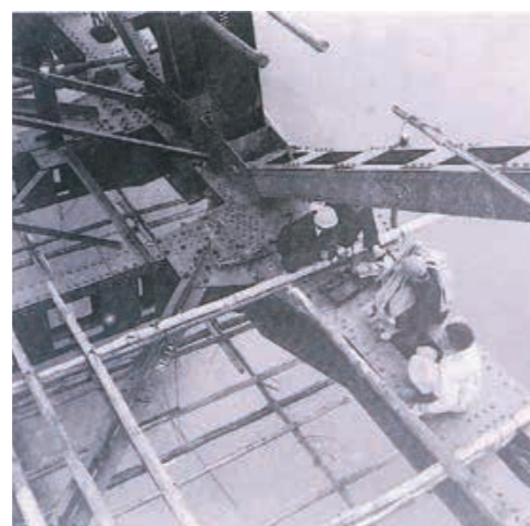
アーチの上の作業員
