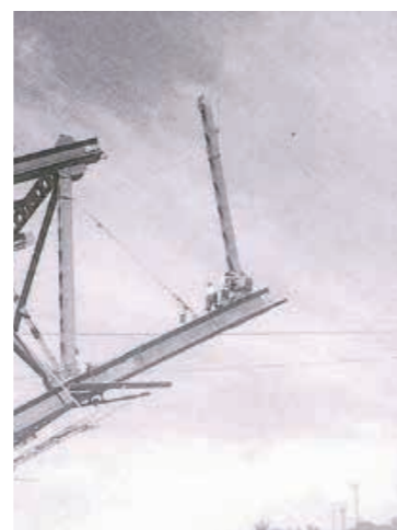
鉄柱の取り付け
