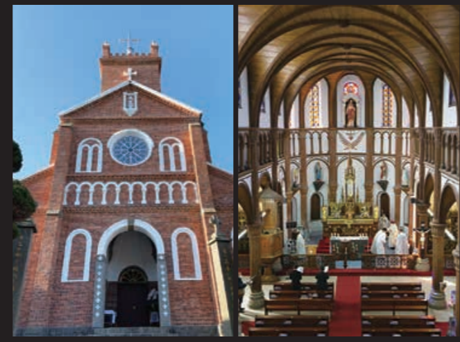
写真左：れんがやしっくいなどの耐震・修復工事が完了した黒島天主堂外部、写真右：2月23日に行われた感謝のミサの様子
