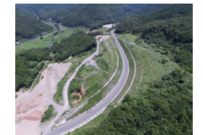
県道の付替道路工事の様子
