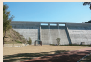
かさ上げ後の下の原ダム
