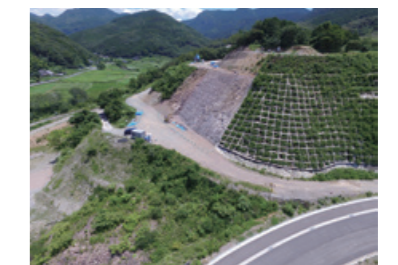
石木ダム本体掘削工の様子
