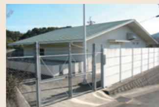
川棚川暫定豊水導水施設
