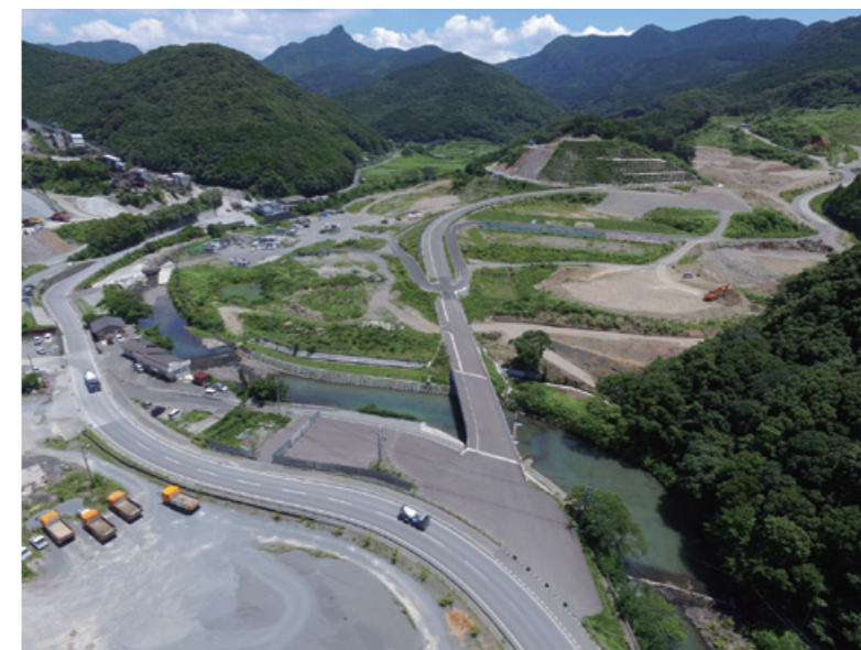
石木ダム工事の全体の様子
