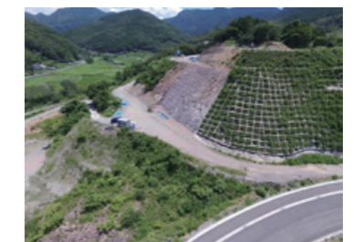
石木ダム本体掘削工の様子
