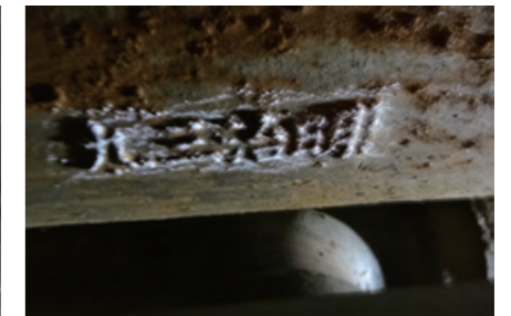
明治39年の刻印がされた導水管(山の田ダム)
