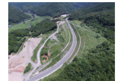
県道の付替道路工事の様子
