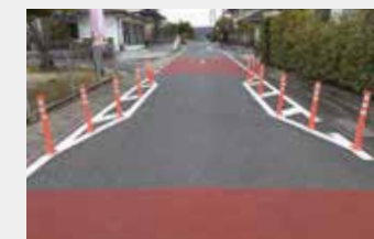
狭さくによって狭くなった道路
