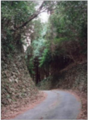
石垣はひと抱えほどの石を高さ六尺ほど積み上げた割り石積みで、工事の苦心の跡がしのべれます。峠の中ほどに切り石の銘板があり、大正十五(一九二六)年の竣工を告げています。土木機械が普及していない時代、地元農家の人々が人夫となって、畚(縄)を綱状にし、四隅に綱をつけて石などを担う道具を使い、石工さんが近くの採石場で適当な大きさに割った石材を運んだのでしょう。
