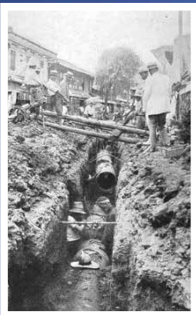
市内で行われた初の水道工事の様子(明治39年ごろ)
