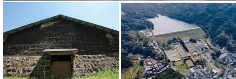
【上】旧山の田浄水場ろ過池用ろ過砂倉庫の内部(明治41年完成)【下左】ろ過砂倉庫の外観【下右】土を台形に盛り上げて造られた「山の田貯水池」(明治41年完成)
